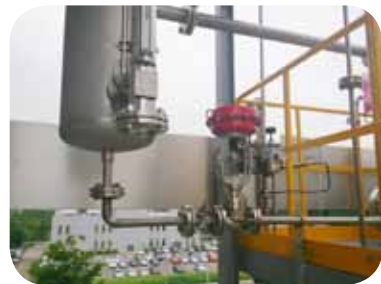
熱水回收至熱回收桶裝置
