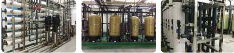
製程回收水 (砂濾、活性炭、RO設備)
