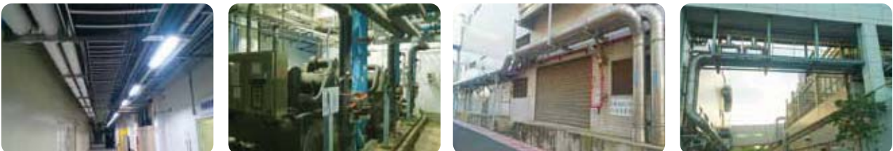
冰水管路系統合併改善
