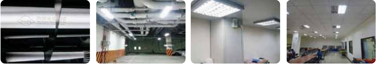
廠內燈管分區汰換為LED燈管
