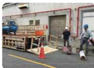
因搬運不慎鋼瓶傾倒
