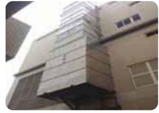
熱排氣回收 ( 降低空調箱外氣補充 )
