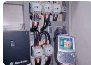
紅外線熱影像儀 ( IR-Scan ) 量測
