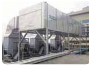
熱排氣回收 ( 降低空調箱外氣補充 )
